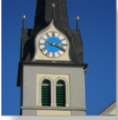
Fassadensanierung Pfarrkirche Eich
